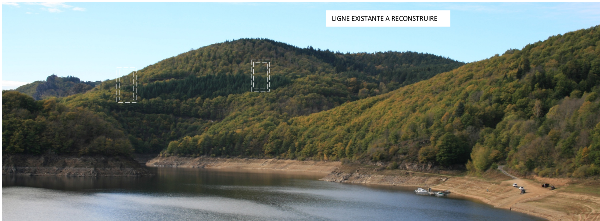
Depuis le Pont de Tréboul et la RD56, les pylônes sont en appui sur la végétation. L'œil peine à les deviner.
