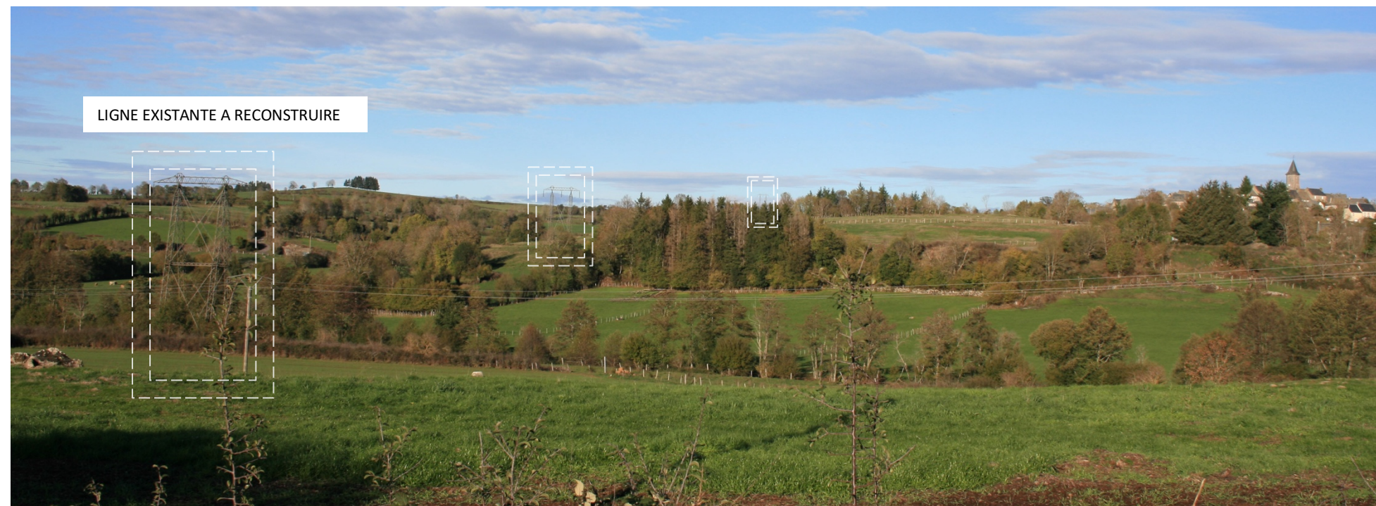
Le relief et la présence de bosquets rendent les pylônes particulièrement peu perceptibles.
