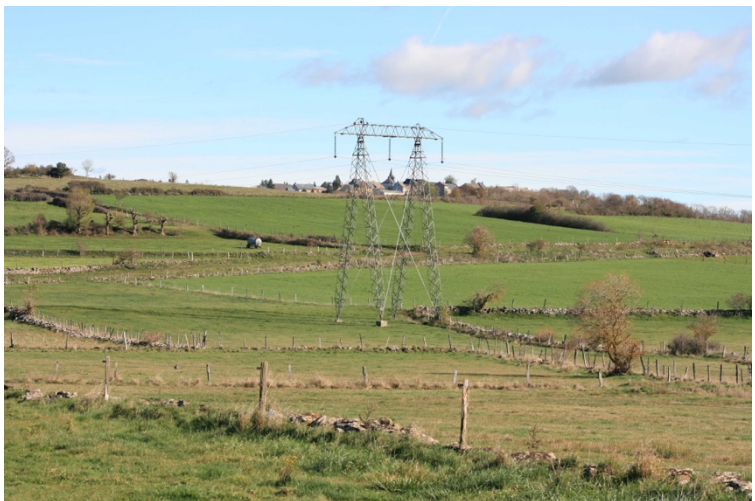
Pylône à déposer.
